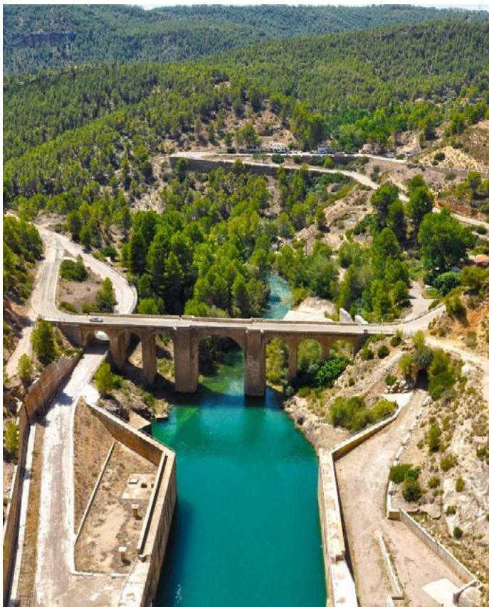
Puente sobre el Río Cabriel en el Puerto de Contreras
