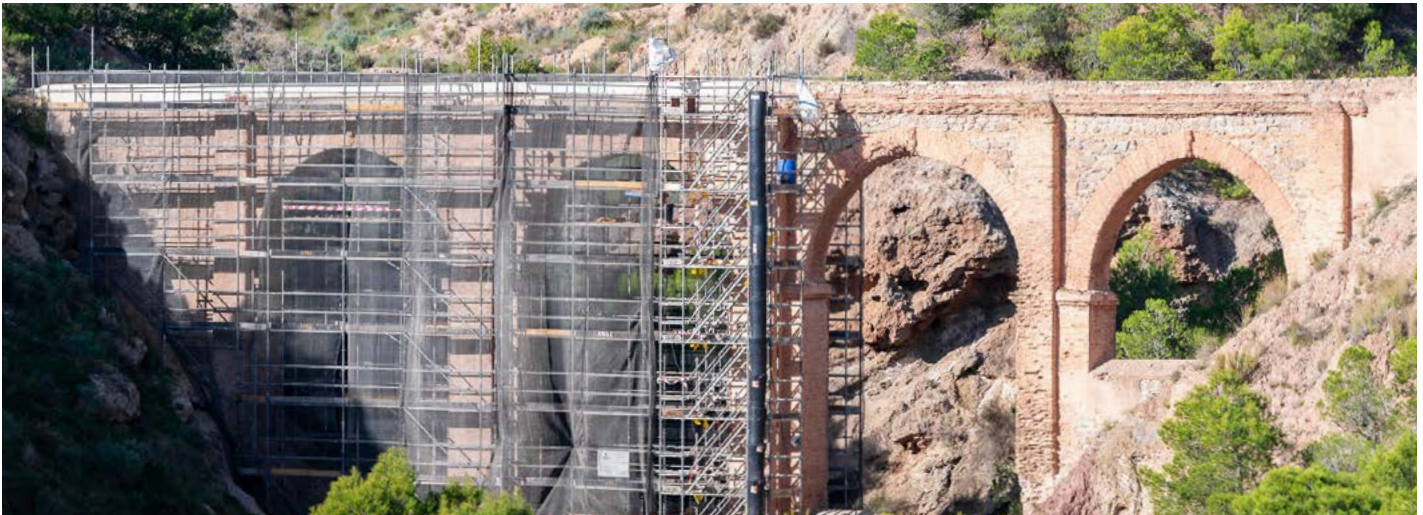
Imagen del Acueducto de los Cinco Ojos durante las obras de consolidación y restauración de la infraestructura
